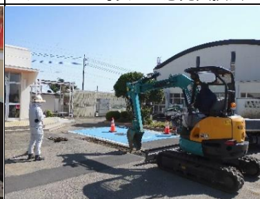
校庭の水道工事
